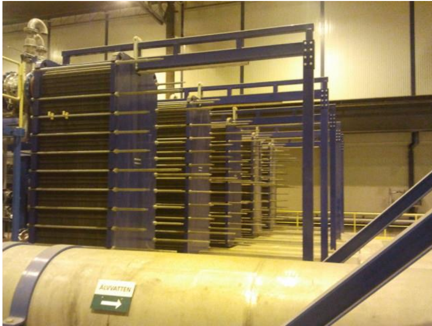
Figur 2.5 – Fem stycken plattvärmväxlare
