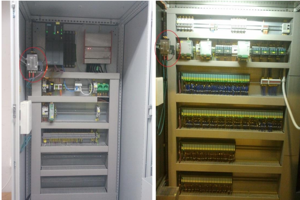
Figur 2.7 - PLC och distribuerat I/O
